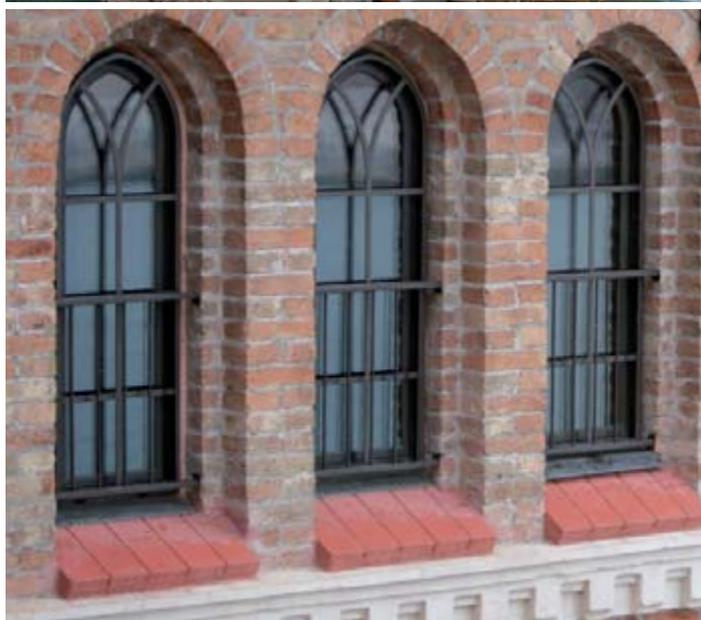
La dimensione dell'intervento ha riguardato ben 1950 serramenti per i quali il dettato architettonico originale è stato filologicamente rispettato, realizzandoli con profili **sistemacciaio** in ottone brunito e dotandoli di un reticolo esterno per mantenerne invariato l'intero e caratterizzante impaginato formale. La versatilità del sistema ha consentito di limitare l'impatto
